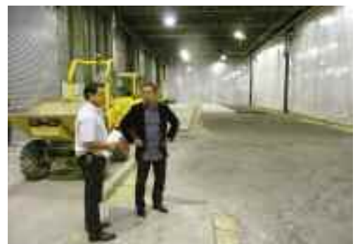
M. Fellmann et Ciguro devant les fondations de la nouvelle presse.
