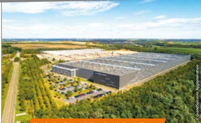
Vue des installations de Houtch sur le Parc du Plateau.
